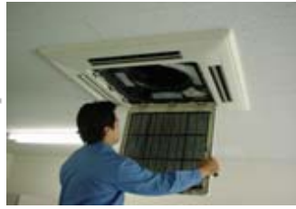
フィルター及び前面パネルを 取り外す。
