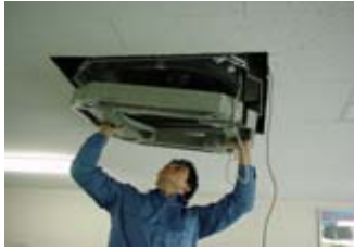
ドレンパンを取り外す。
