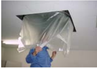
機械本体を養生（養生マス カーを巻く）
