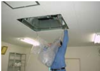
マルチホッパー及び養生マス カーを取り外す。
