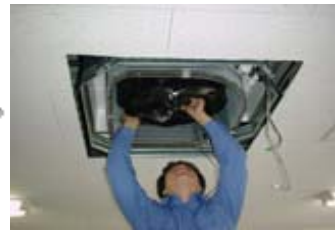
洗浄した部品を本体に取り付 ける。
