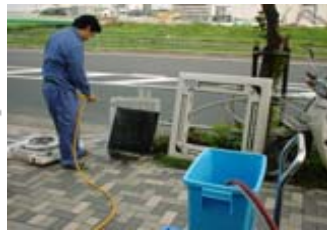
分解作業にて取り外した部品 を別場所にて洗浄する。
