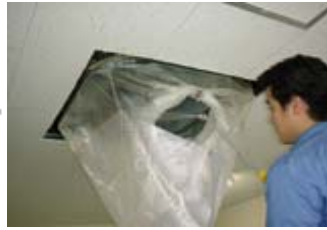
高圧洗浄機にて水洗浄する。
