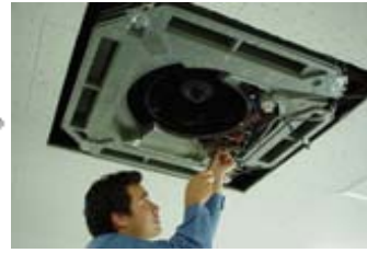
分解作業（電気配線、コネク タ類の取り外し）
