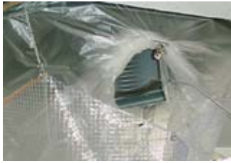
洗浄剤をスプレーにて塗布す る。
