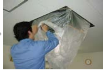
養生マスキングの一部をクリッ プで押さえる。
