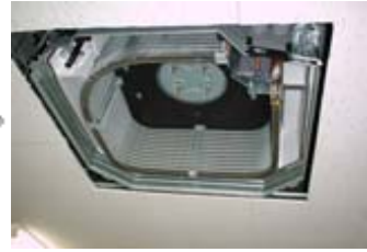
分解作業終了（熱交換器が剥 き出しになった状態）
